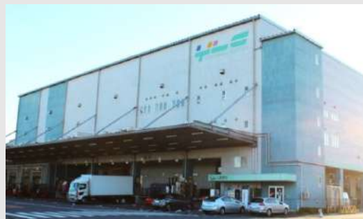
第1フレッシュセンター(5階建、9,363㎡、冷蔵庫、自動倉庫)
